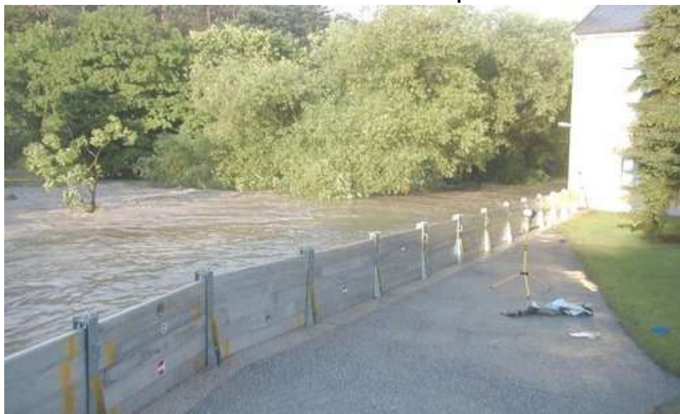
Măsurile de protecție împotriva inundațiilor.
